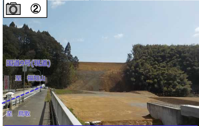
令和4年度の土工事が完成しました。
