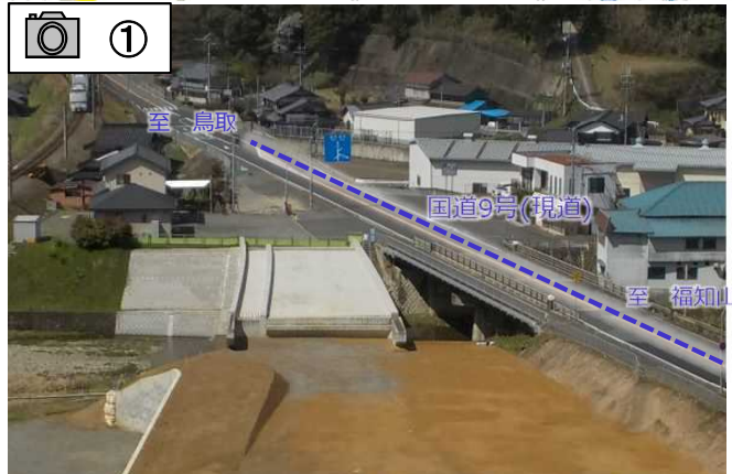
令和4年度の橋梁工事が完成しました。
