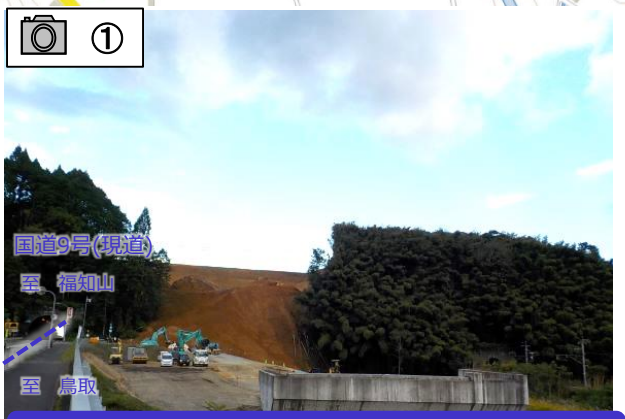
切土工事を行っています。
