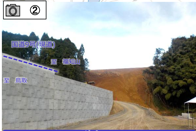
道路を作るための擁壁工事を行っています。
