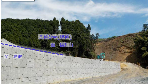
道路を作るための擁壁工事をしています。
