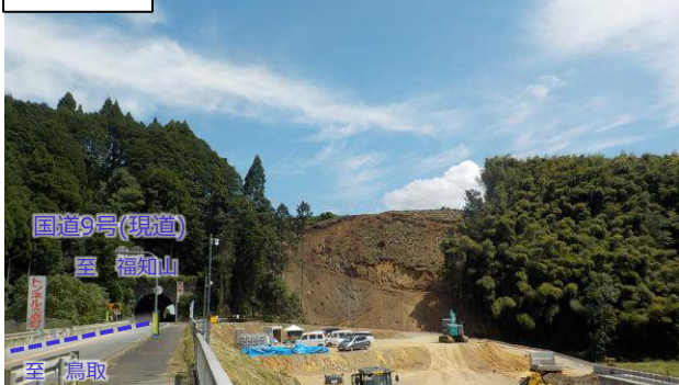
伐採が完了しました。(切土工事の準備中です。)
