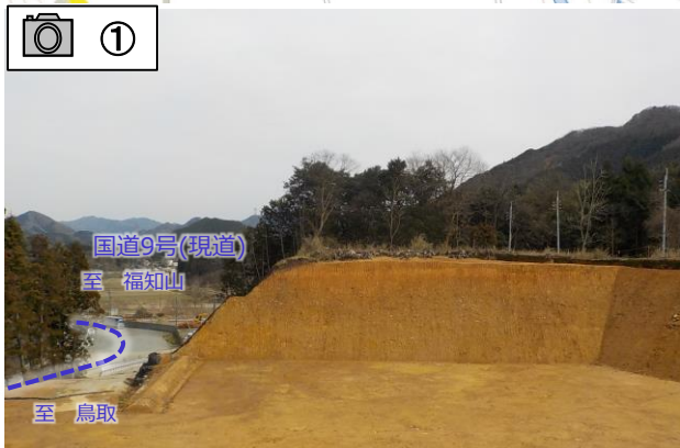
令和3年度の切土工事が完了しました。
