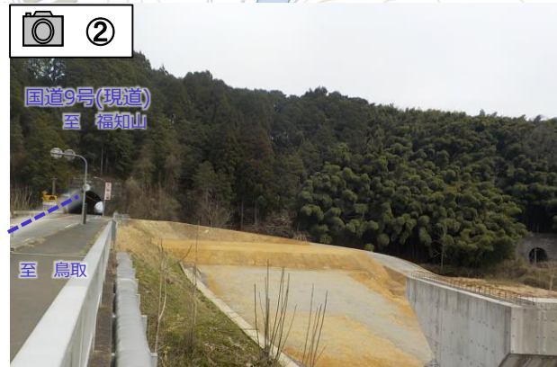
令和3年度の盛土工事が完了しました。
