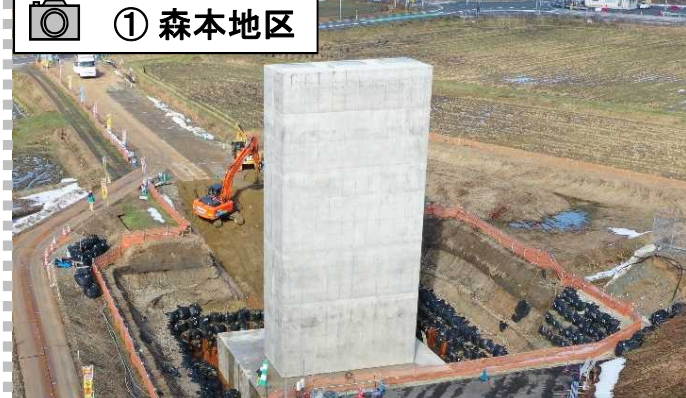
橋脚が完成しました。あとは埋戻しをします。
