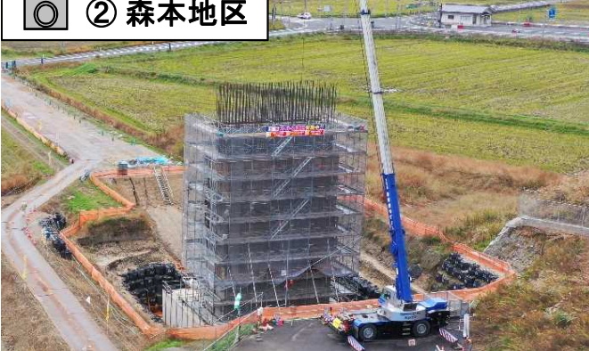
コンクリートを流し込む作業を開始しました。
