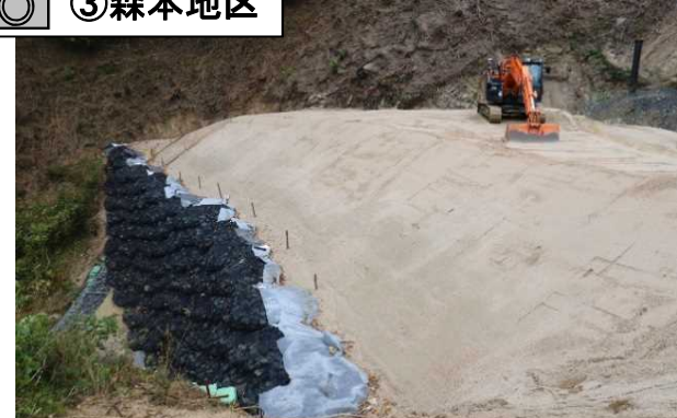
工事用道路を造るため、谷筋の盛土に着手しました。
