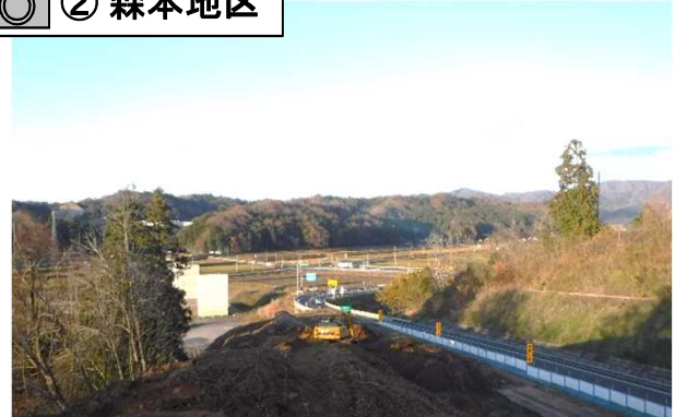
第1高架橋A1橋台箇所 の 樹木伐採が完了し、掘削を進めています。
