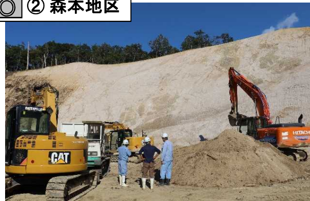
幅3mの工事用道路をつくるため、山を掘削して土砂を搬出しています。
