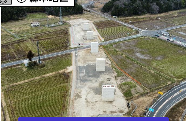
令和3年度の橋脚工事が完了しました。
