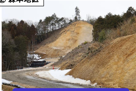
切土工事をしています。
