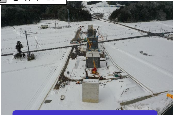
橋脚工事をしています。
