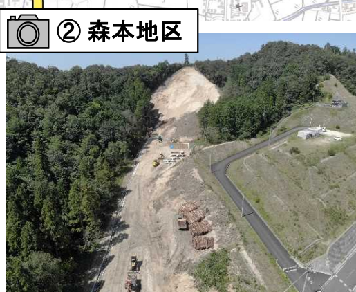
伐採や切土を行っています。
