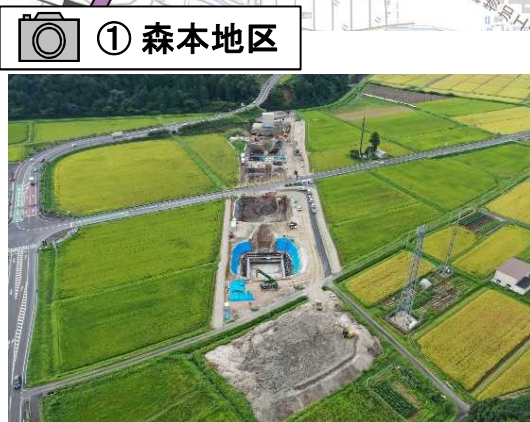
橋脚工事をしています。
