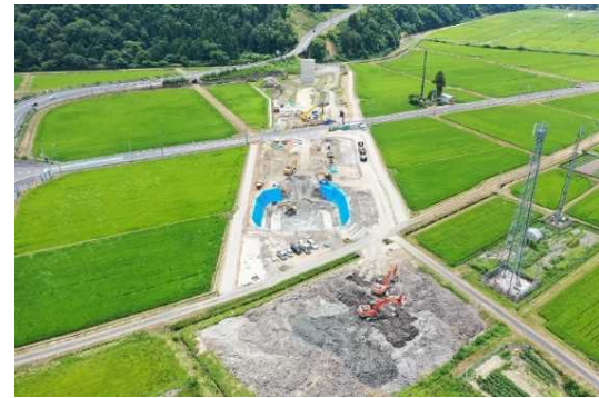
橋脚工事の準備をしています。
