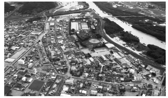
△平成26年8月豪雨による福知山市街地の浸水状況
