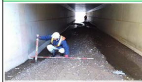
排水門の点検
