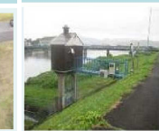
21.味方第一樋門
