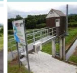
16.位田第一樋門
