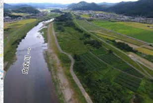
河道掘削・樹木伐採（私市地区等）
