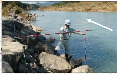
(番号11) 綾部市大島町 河岸崩落 約316m
