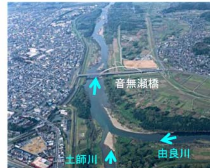
写真 2.3.8 福知山市市街地付近 (36k~38k 付近)
