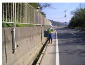
写真 4.4.3 洪水痕跡調査
