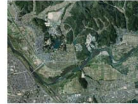
写真 4.4.2 空中写真による河道の状態把握（土師川との合流点付近）
