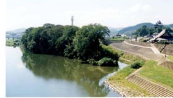
写真 2.3.15 現在の明智敷の状況
