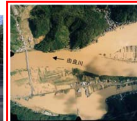
写真 4.4.4 洪水時の空中写真（大川橋付近）
