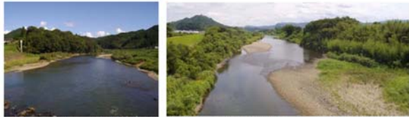
写真 2.4.5 由良川の河道内樹木繁茂状況（左：波美橋付近（25k）、右：以久橋付近（48k））
