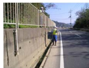
写真 4.4.3 洪水痕跡調査
