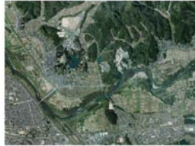
写真 4.4.2 空中写真による河道の状態把握
