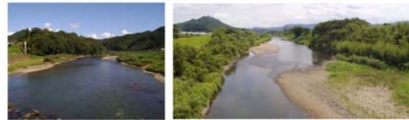
写真 2.4.5 由良川の河道内樹木繁茂状況 （左：波美橋下流付近（24.8k 付近）、右：以久橋上流付近（47.6k 付近））
