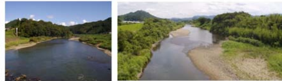
写真 2.4.5 由良川の河道内樹木繁茂状況（左：波美橋付近（25k）、右：以久田橋付近（48k））
