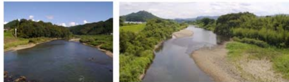
写真 2.4.5 由良川の河道内樹木繁茂状況（左：波美橋付近（25k）、右：以久田橋付近（48k））
