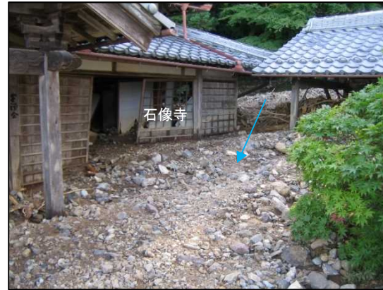
平成26年豪雨時 被災状況
