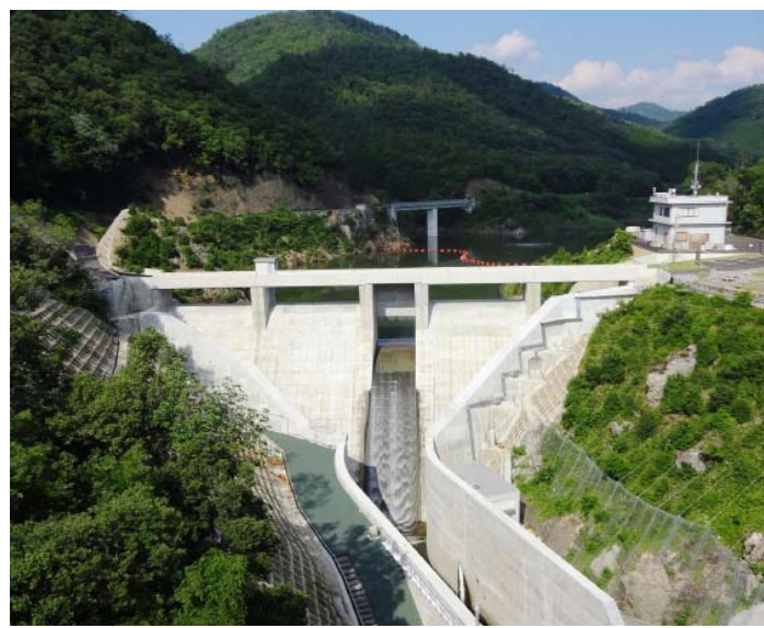
畑川ダム全景写真
