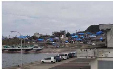
令和元年房総半島台風 (気象庁職員撮影)
