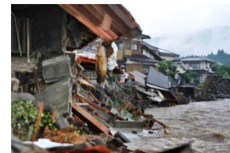
河岸侵食による家屋の流失 〔写真提供／西日本新聞社〕 河岸侵食により家屋倒壊した状況
