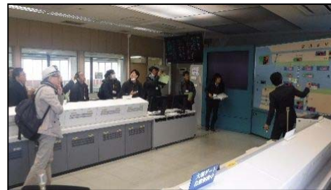
毛馬排水機場
