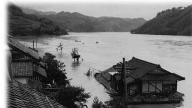
S28 山麓間見渡す限り浸水
