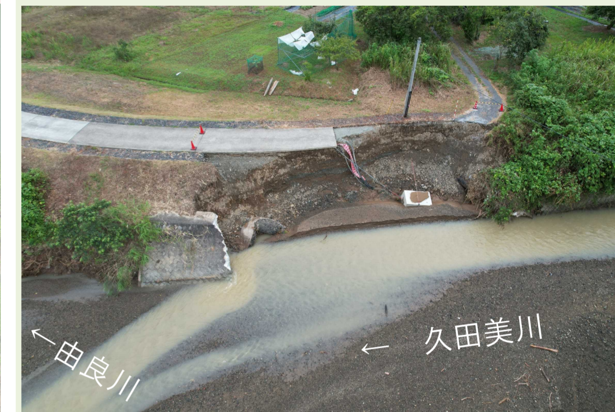
右岸11.0k付近 久田美川合流部 応急復旧
