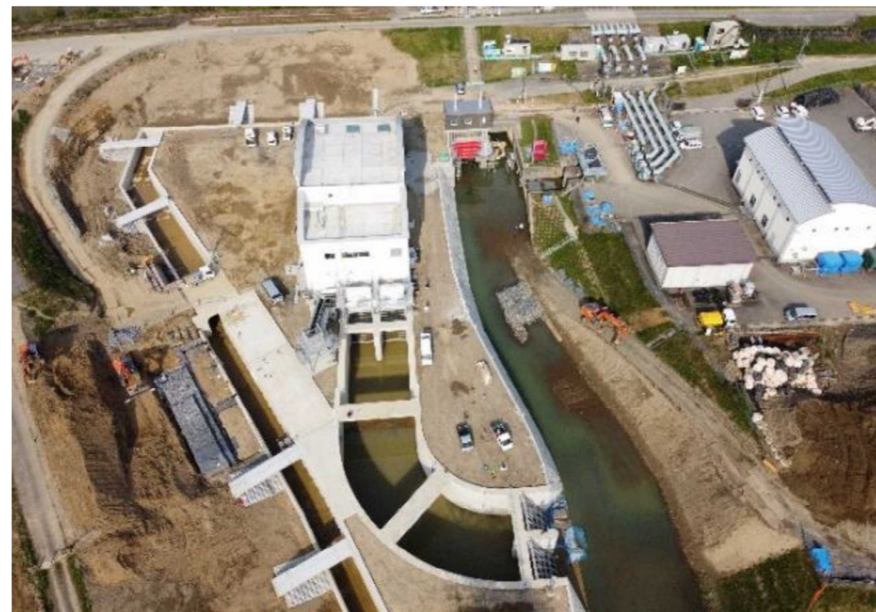
弘法川排水機場
