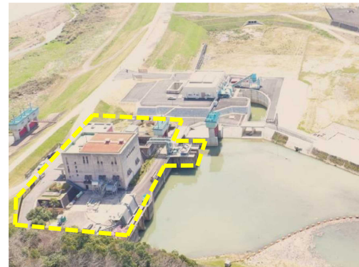
荒河排水機場
