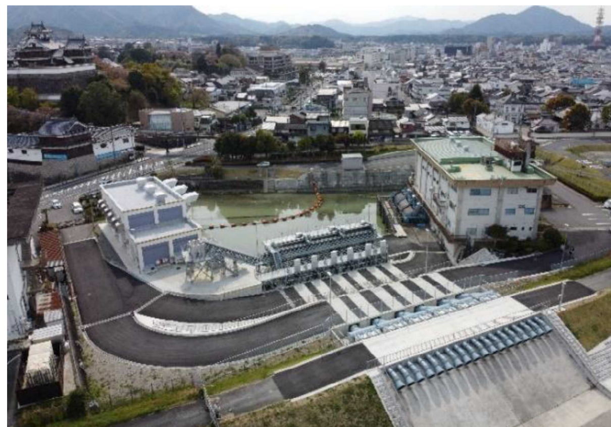
法川排水機場
