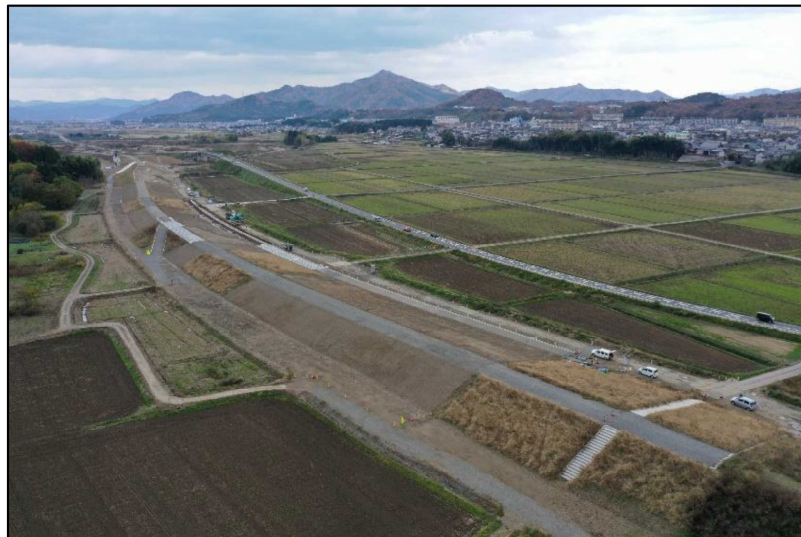
▲由良川中流部連続堤防（前田地区）
