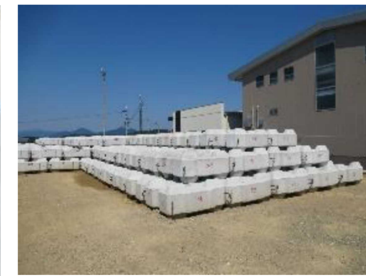
根固めブロック
