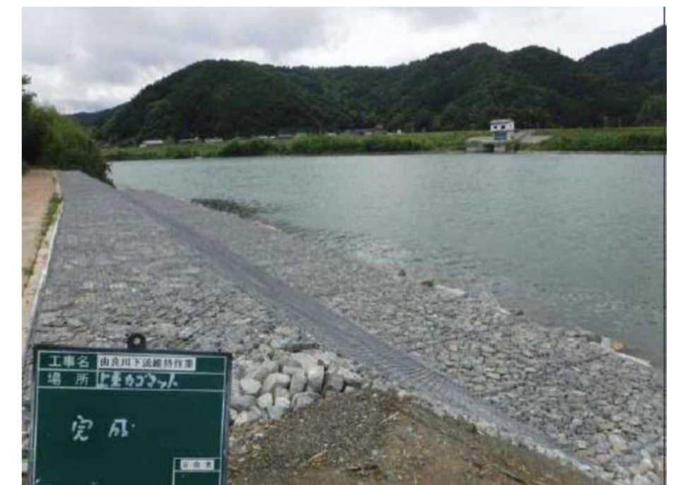
維持修繕工事
