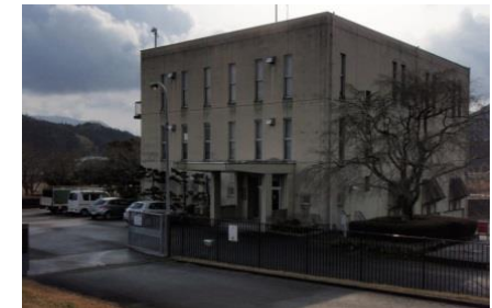
▲荒河排水機場
