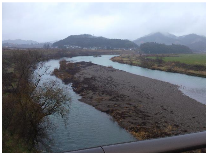
▲土砂堆積のようす
