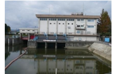
▲法川排水機場
