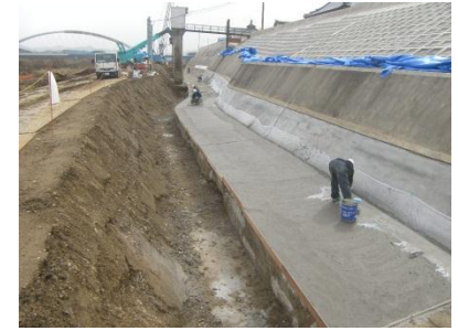
堤防補修状況
