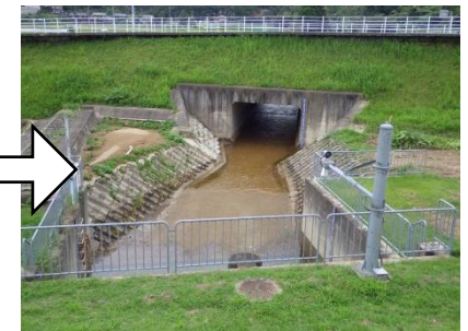
応急対策実施状況(出水による樋門への土砂堆積解消)
