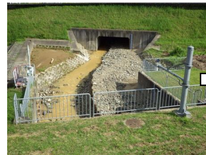
応急対策実施状況(出水による樋門への土砂堆積解消)
