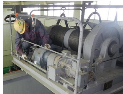
排水機場点検状況
