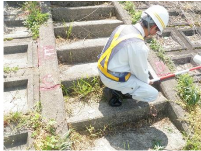
点検実施状況
