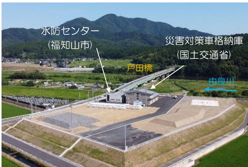
▲由良川防災ステーション
