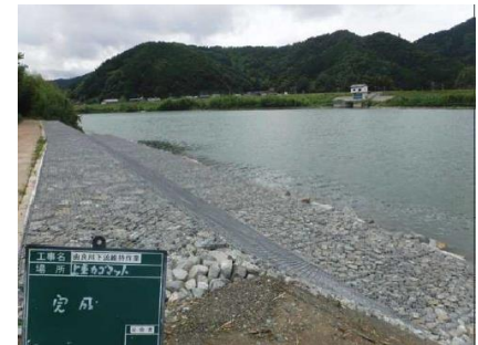
維持修繕工事
