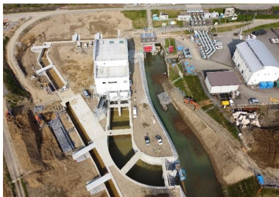
弘法川排水機場
