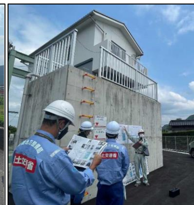
▲綾部市雨水ポンプ場
