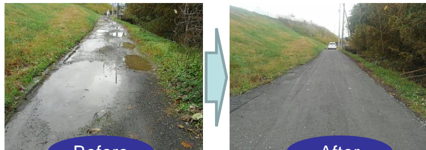
管理用通路の整備
