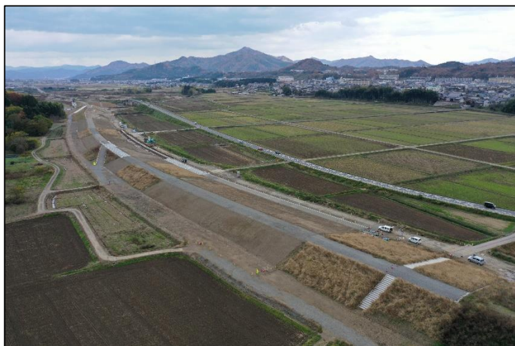
▲由良川中流部連続堤防（前田地区）
