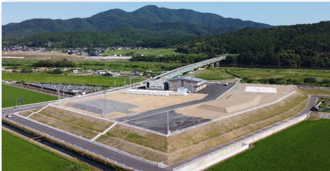
由良川防災ステーション
