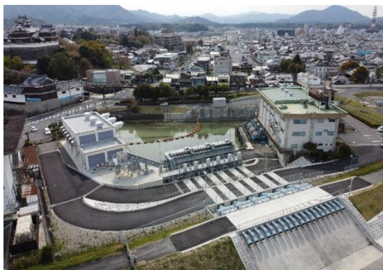
法川排水機場
