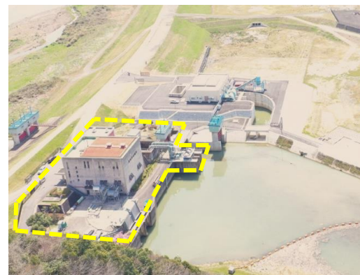
荒河排水機場
