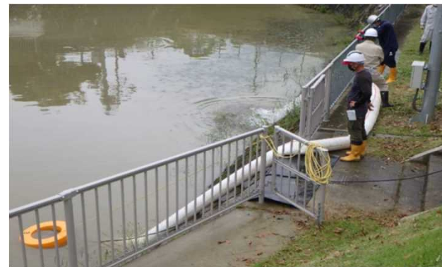
▲排水作業訓練の状況
