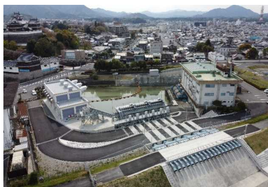
法川排水機場
