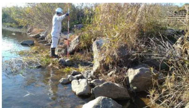
▲施設点検の様子（護岸）
