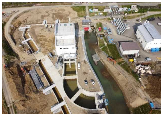
弘法川排水機場
