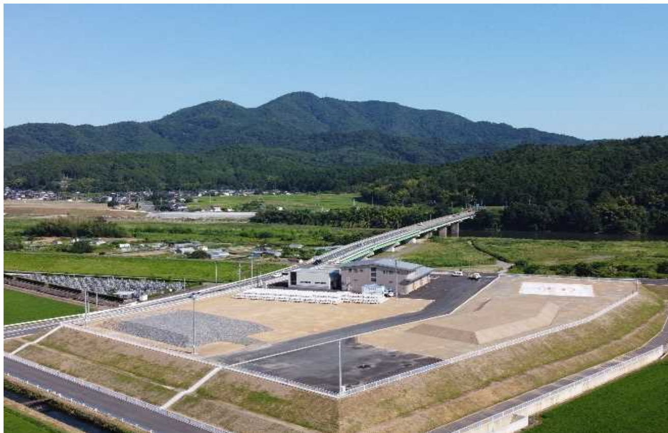
由良川防災ステーション
