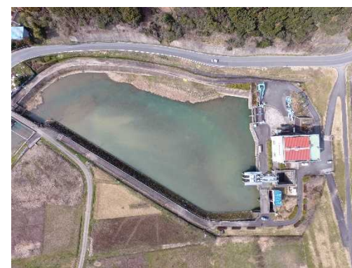
荒河排水機場
