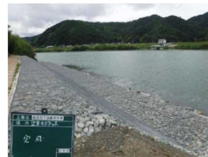
維持修繕工事
