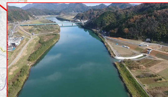
▲水田谷川樋門（舞鶴市）
