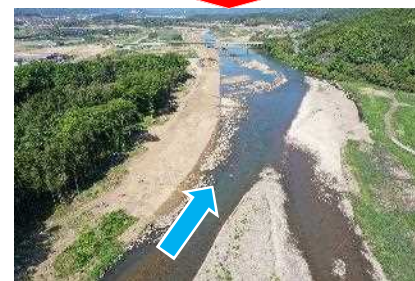
▲戸田地区（河道掘削）
