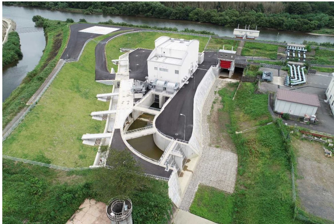
弘法川排水機場
