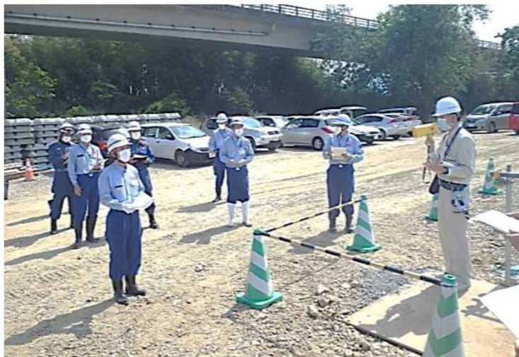
▲工事の説明風景
