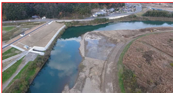
▲引谷川樋門（福知山市）
