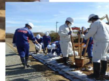
▲土のう積みの様子
