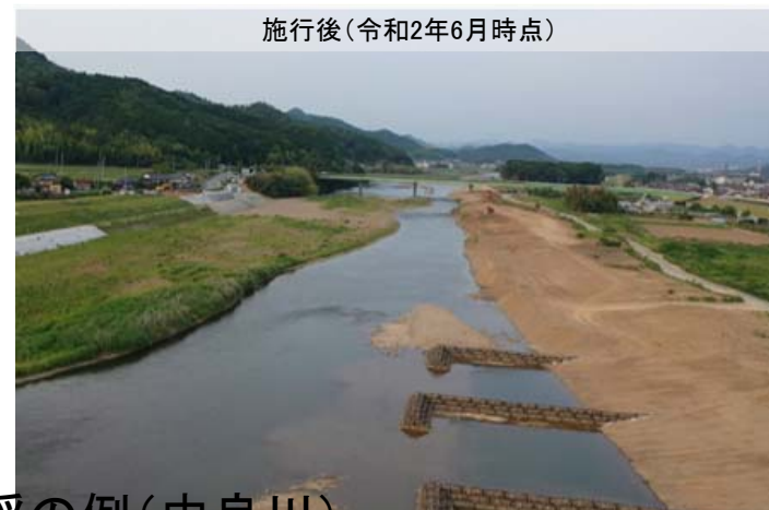
河道掘削及び樹木伐採の例(由良川)
