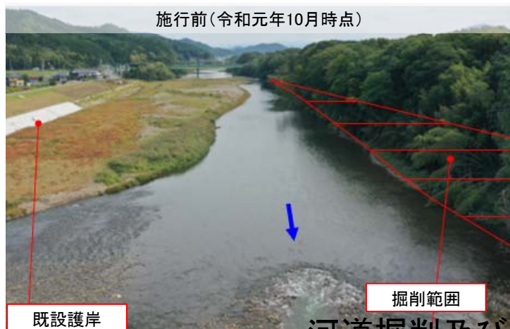
河道掘削及び樹木伐採の例(由良川)
