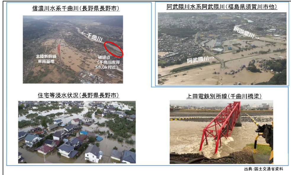
台風19号の被害状況
