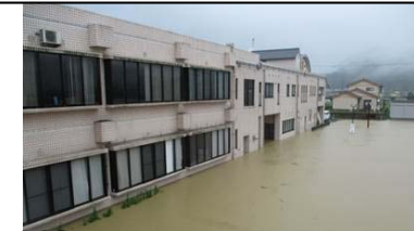
大江支所 浸水状況 (平成30年7月豪雨時)
