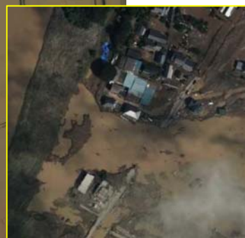
鬼怒川破堤付近を拡大
