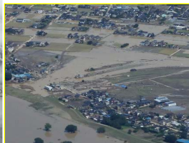
破堤箇所の拡大
