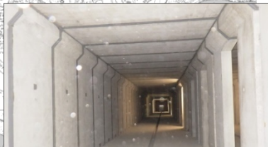
小谷ヶ丘貯留施設工事中 【能力】2,440m 3
