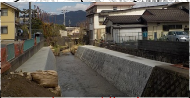
法川河川改修工事 (全体延長1.2kmのうち約60m完成)
