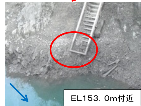
管理用船舶の係留施設
