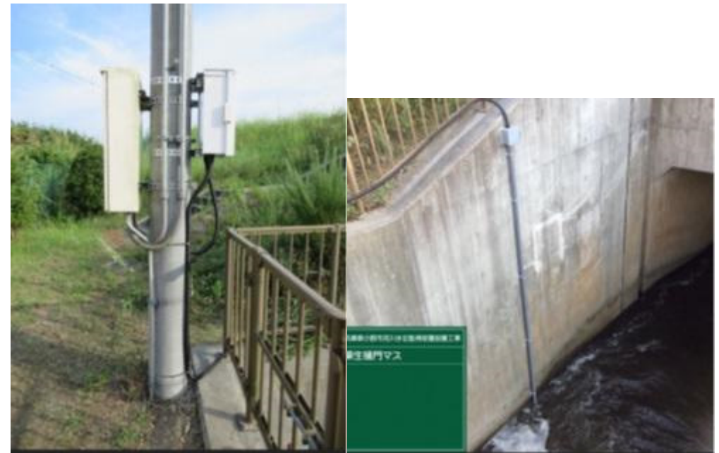
【水位計測システム イメージ】
