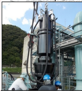
荒河排水機場[国] 3m 3 /s緊急排水ポンプ増設
