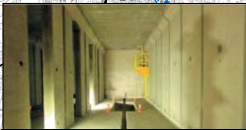
大正東貯留施設完成 [能力]1,500m 3
