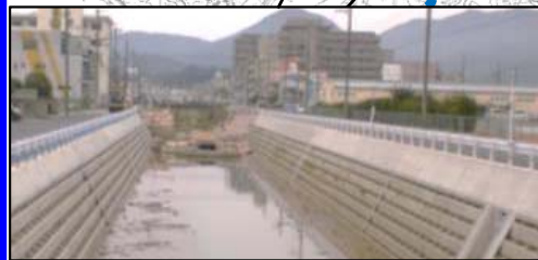
弘法川河川改修工事 (全体延長1.4kmのうち約100m完成)
