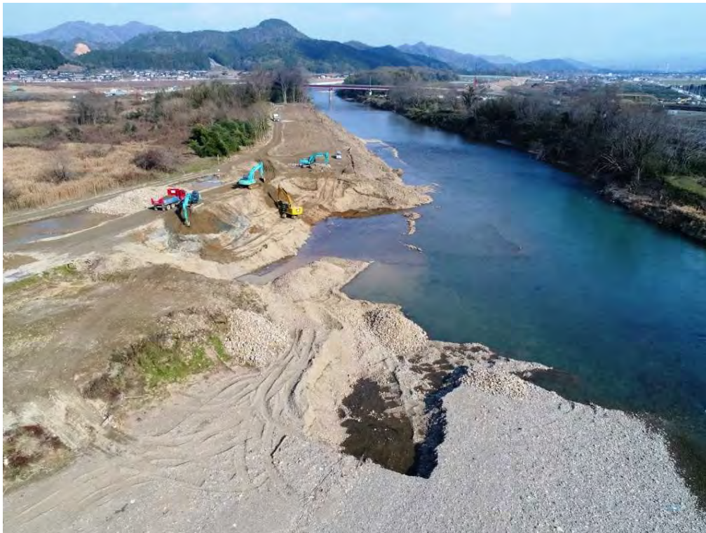
川北地区河道掘削(H31. 1時点)
