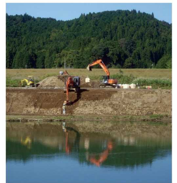
河道掘削イメージ
