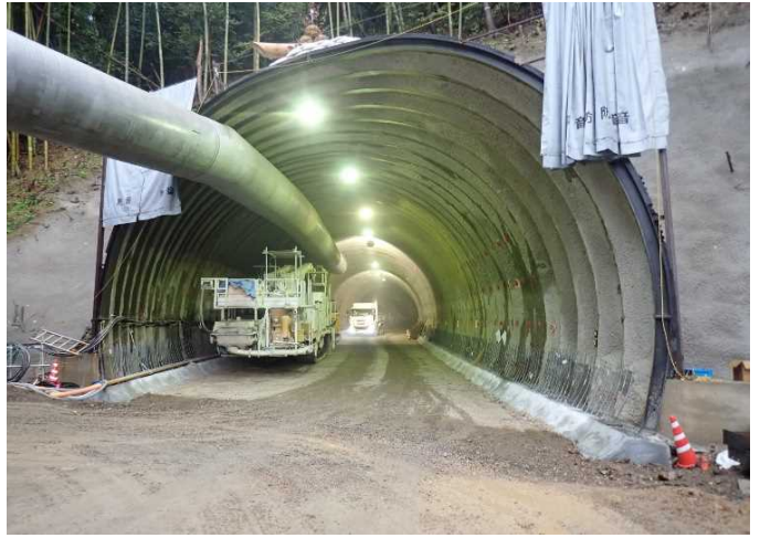
掘削後(起点側)
