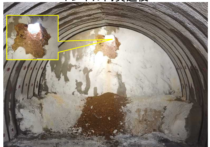
トンネル内貫通後
