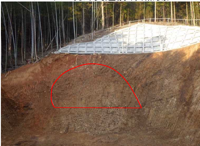
トンネル坑外貫通前(終点側)
