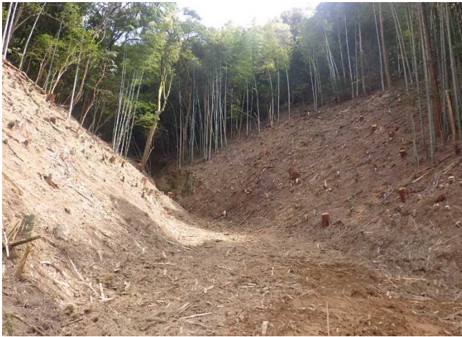
掘削前(起点側)
