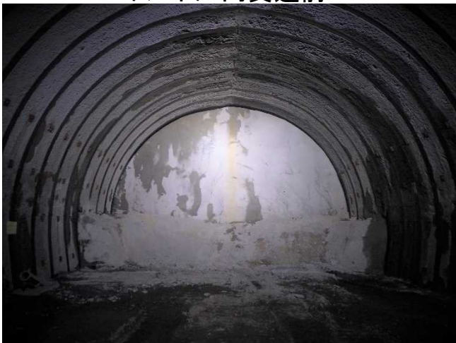
トンネル内貫通前
