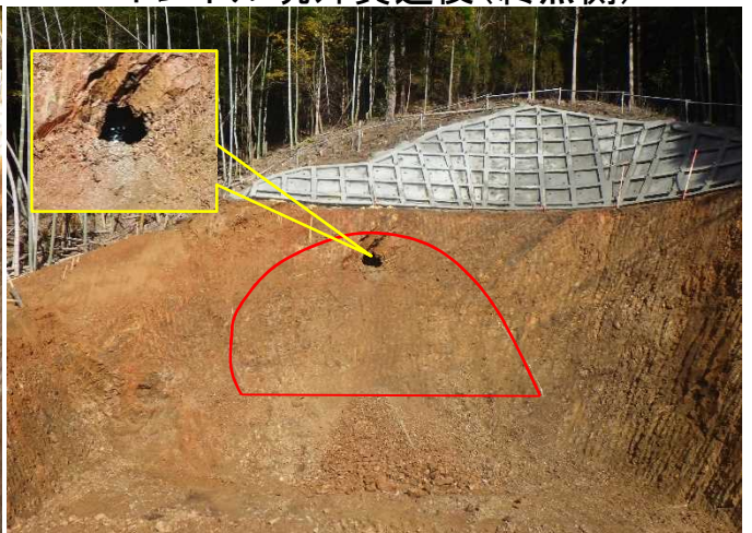
トンネル坑外貫通後(終点側)
