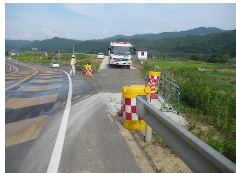
碎石の敷設により、アクセス性を改善
