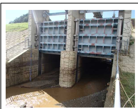
土砂堆積時の様子(蓼原川樋門)
