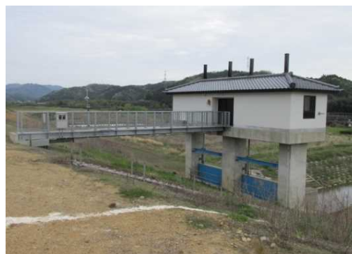
志高中央樋門(堤防側から)
