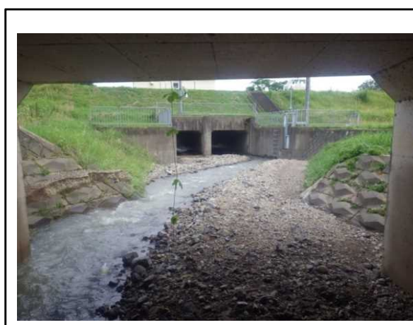
土砂堆積時の様子(東谷川樋門)
