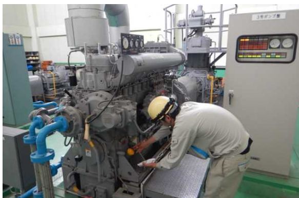
排水機場点検の様子
