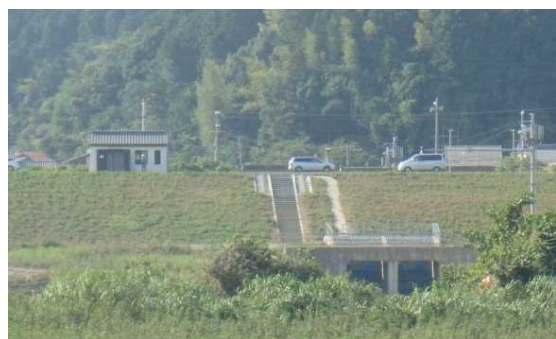
谷河川樋門(河川側から)
