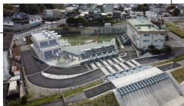
▲法川排水機場
