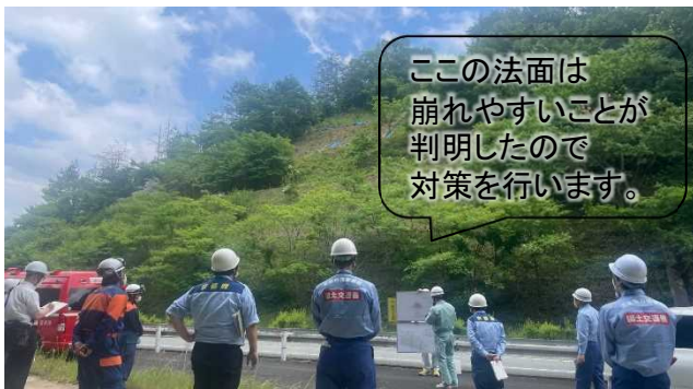
府道小浜綾部線 法面对策工事(綾部市十倉志茂町)
