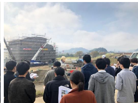
▲弘法川排水機場の工事現場
