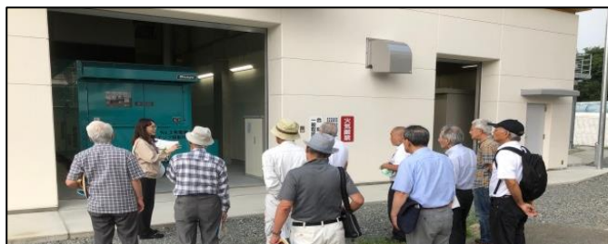
発電設備の説明
