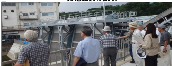
法川排水機場増強工場の説明
