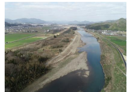
河道掘削(福知山市前田地区)
