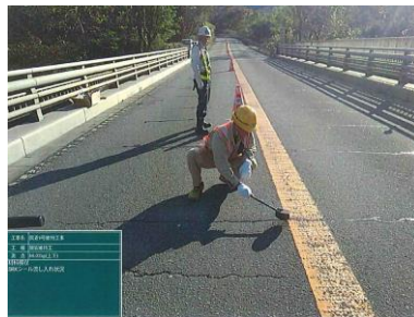
ひび割れ補修（注入）
