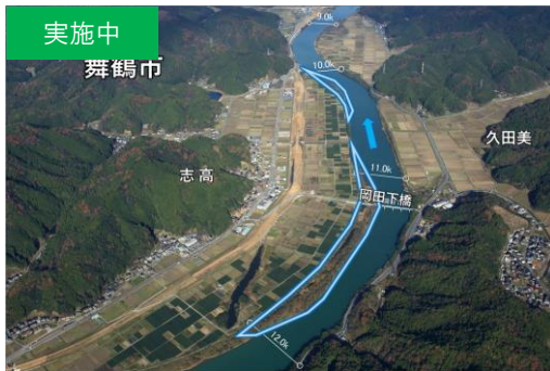
河道掘削(舞鶴市志高地区)
