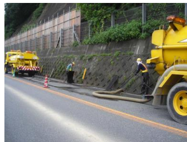
排水構造物清掃
