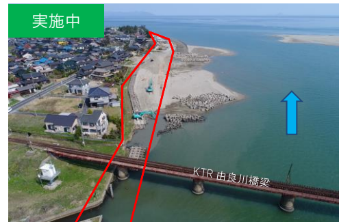
堤防整備(宮津市由良地区)
