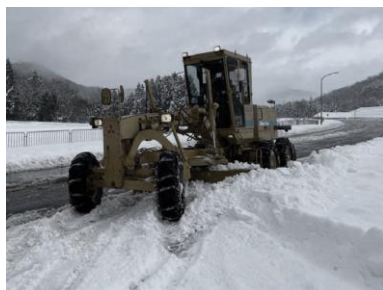
拡幅除雪（除雪グレーダ）
