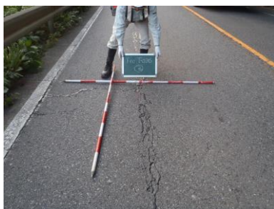
舗装（路面）点検
