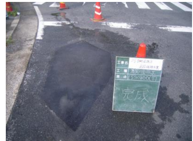
凹凸補修（パッチング）
