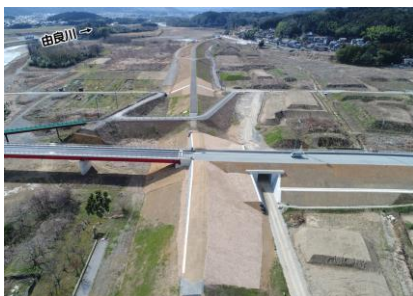
連続堤(福知山市川北地区)
