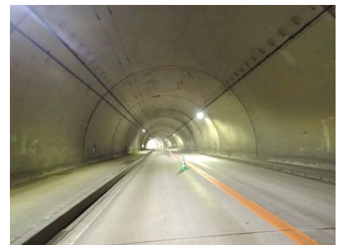
国道27号和知トンネル
