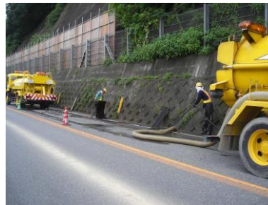
排水構造物清掃
