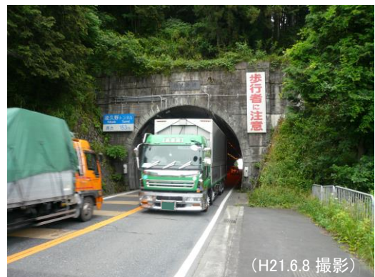
夜久野トンネル
