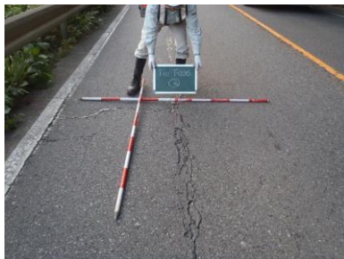
舗装（路面）点検
