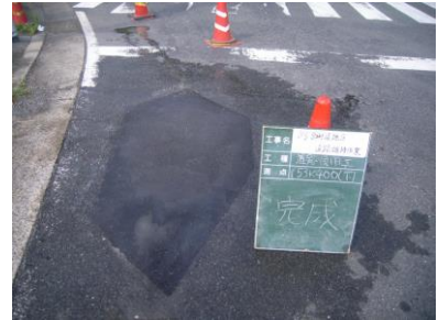
凹凸補修（パッチング）
