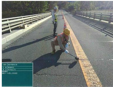
ひび割れ補修（注入）
