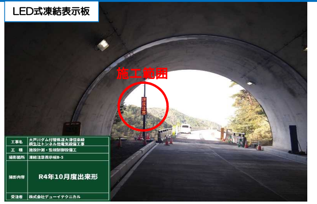
桐生辻トンネルから撮影
