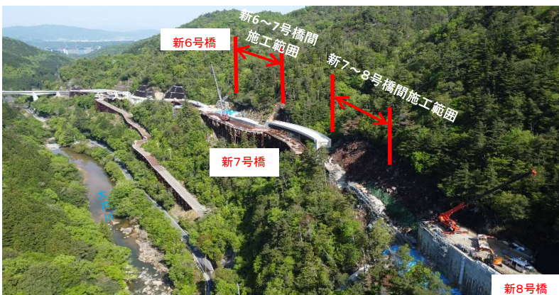
工事現場全景(新8号橋から新3号橋に向けて)
