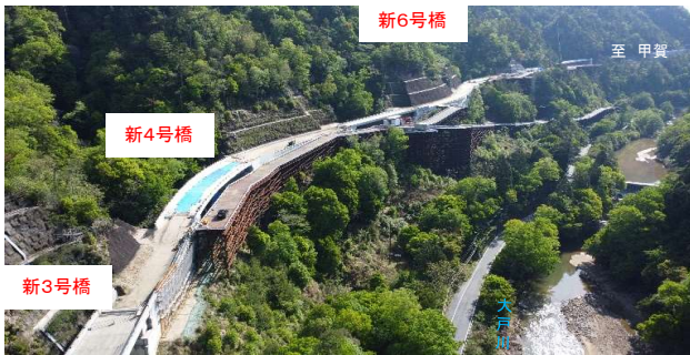
工事現場全景(新3号橋から新8号橋に向けて)
