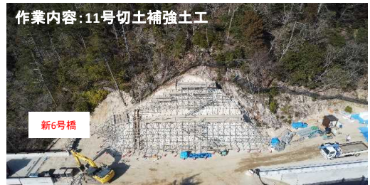
新6～7号橋間施工箇所
