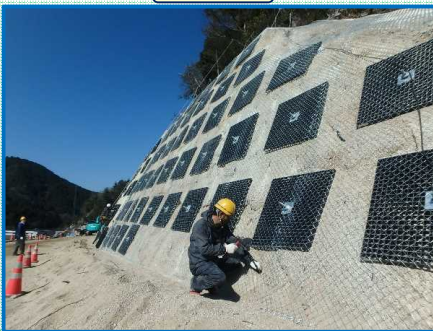
ラス張施工状況
