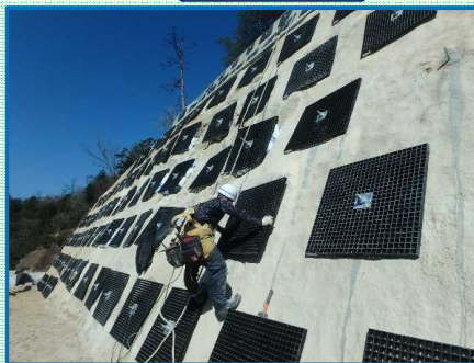
緑化型受圧板設置状況
