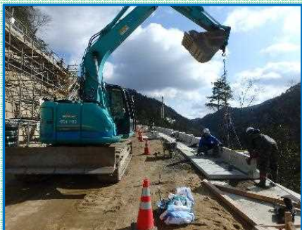
プレキャストガードレール基礎据付状況
