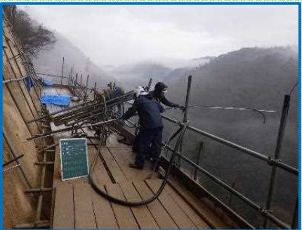
削孔後鉄筋挿入状況
