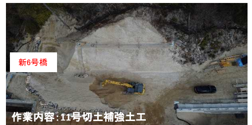
新6~7号橋間施工箇所
